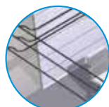
3-rurowa instalacja czynnika chłodniczego
